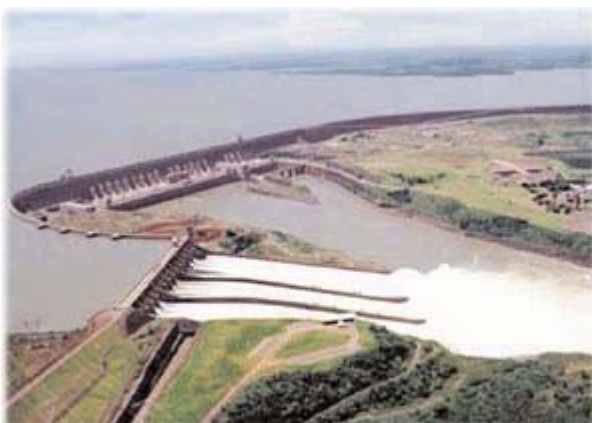
La Presa Itaipú en Brasil estableció la planta hidroeléctrica más grande del mundo sobre el Río Paraná. Foto de U.S. Geological Survey
